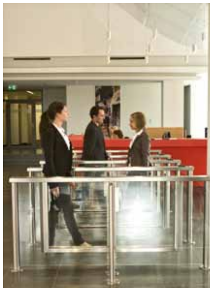
Doppelte Zugangskontrolle - Sensorschleuse mit Erweiterungsanlagen
