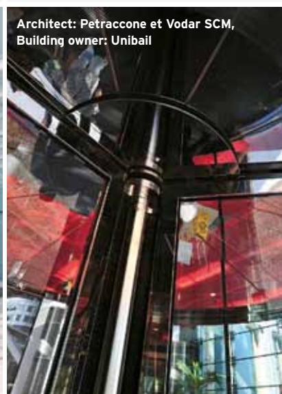
Fluchtwegegeprüftes Türflügelkreuz - Flügel manuell abklappbar, so dass fliehende Personen ohne Hindernis ins Freie gelangen können.
