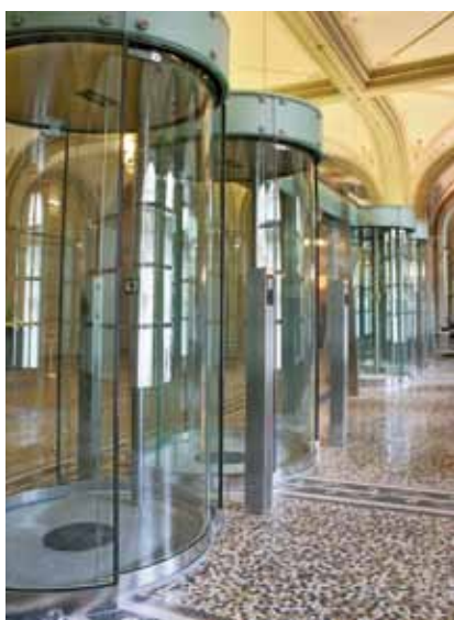
Ganzglas-Mehrfachanlage fügt sich harmonisch im historischen Gebäude ein
